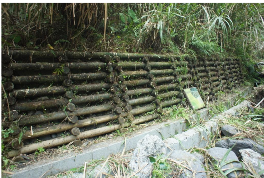
照片 1 木製生態工法木格框擋土牆完成圖 (台灣案例) 南投處仁澤溫泉附近
