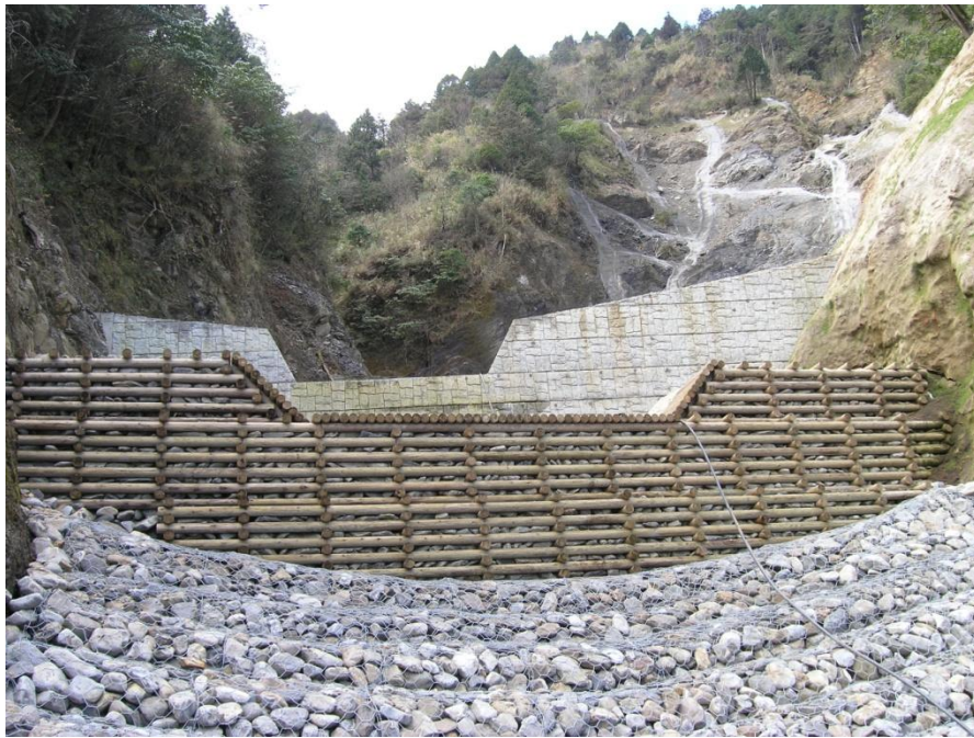
照片 3 宜專一線 23.9km 木格框節制壩完成圖
